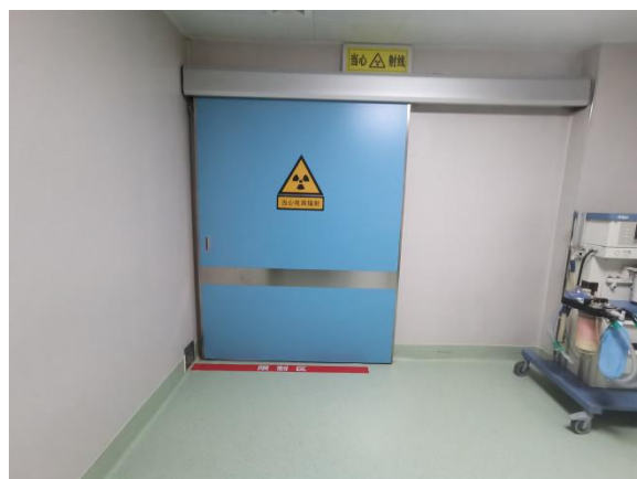
图 4-5 病人通道铅门、警示标志、工作指示灯
